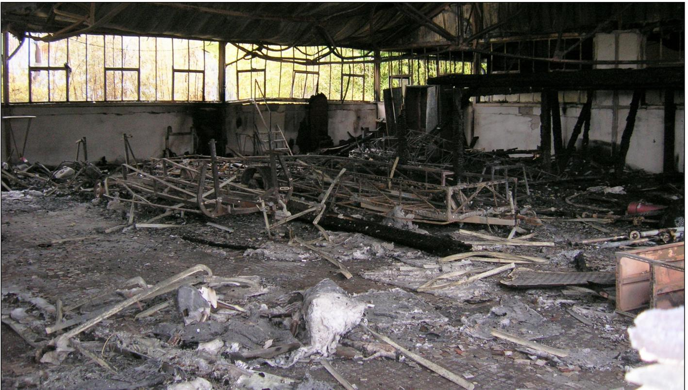
Au premier plan les restes du Cricri, puis la remorque du Pou du ciel HM 14 sur laquelle il était posé , à ses côtés la remorque porte planeur. La charpente du toit s'est affaissée et dans le fond, la verrière s'est tordue sous l'effet de la chaleur.
